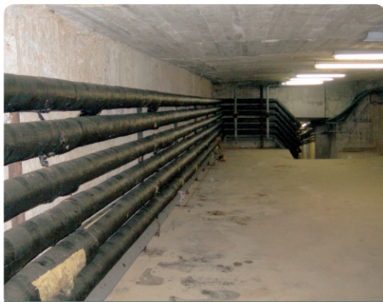
Espais confinats. Galeries.
